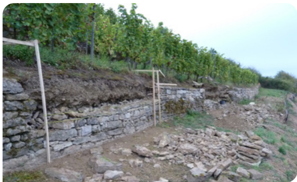
Restauration d'un mur en pierre sèche
